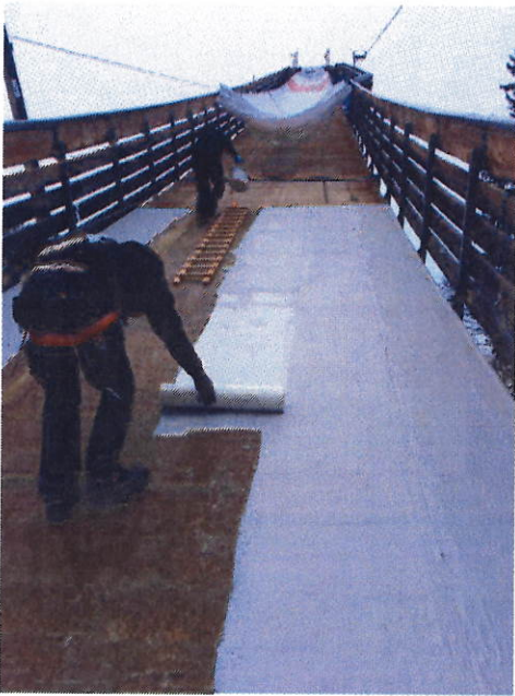
Bild 2 Bei der Verlegung der Abdichtung in Längsrichtung wurden Längen von jeweils ca. 5 m hergestellt. Im oberen Teil hat die Schanze eine Steigung von 39° und der Schanzenkopf als höchster Punkt liegt mehr als 70 m über dem umgebenden Gelände.
